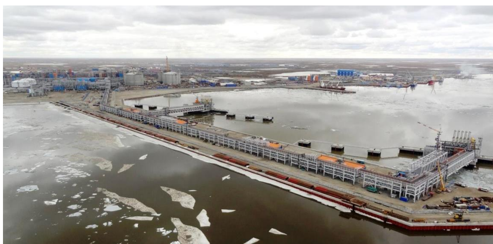
Рис. 5.9. Портовые сооружения завода «Ямал СПГ» в поселке Сабетта (фото В.И.Богоявленского из вертолета 2 июля 2017 г.)
